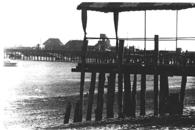
pier @ bay edge
