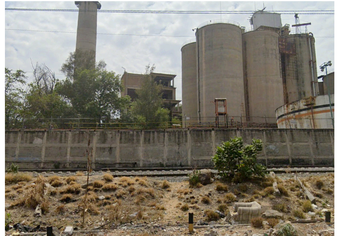
Muchas de estas áreas presentan constante acumulación de basura Many of these areas have constant garbage accumulation
