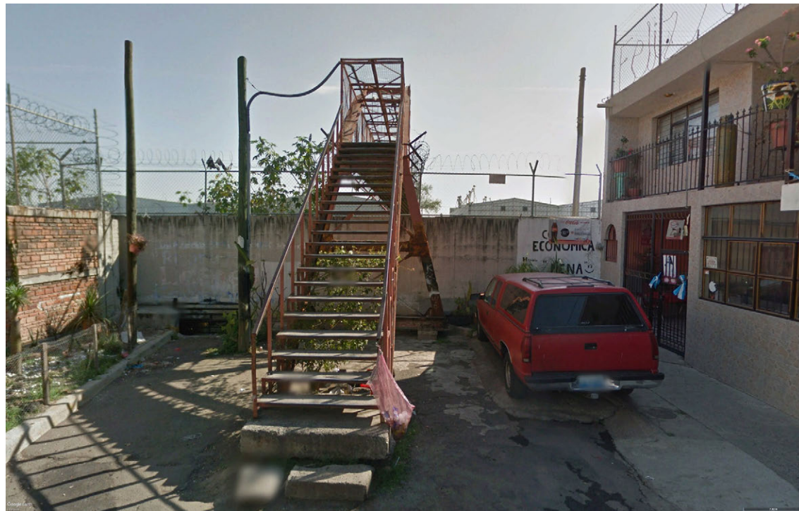
Lado "A" del puente. Nace de la barda aladaña a una casa habitación. Imagen: Google Earth Side "A" of the brige. Starts from the wall next to a house. Image: Google Earth
